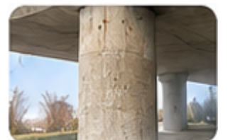
เสาเข็ม และโครงสร้างคอนกรีต
